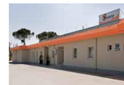
Le siège social et l'usine de production
